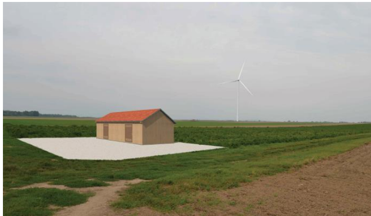
Figure 4 : Présentation des postes de livraison regroupés en une seule structure
